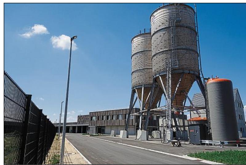
Die zwei Salzsilos und die Soleanlage.
