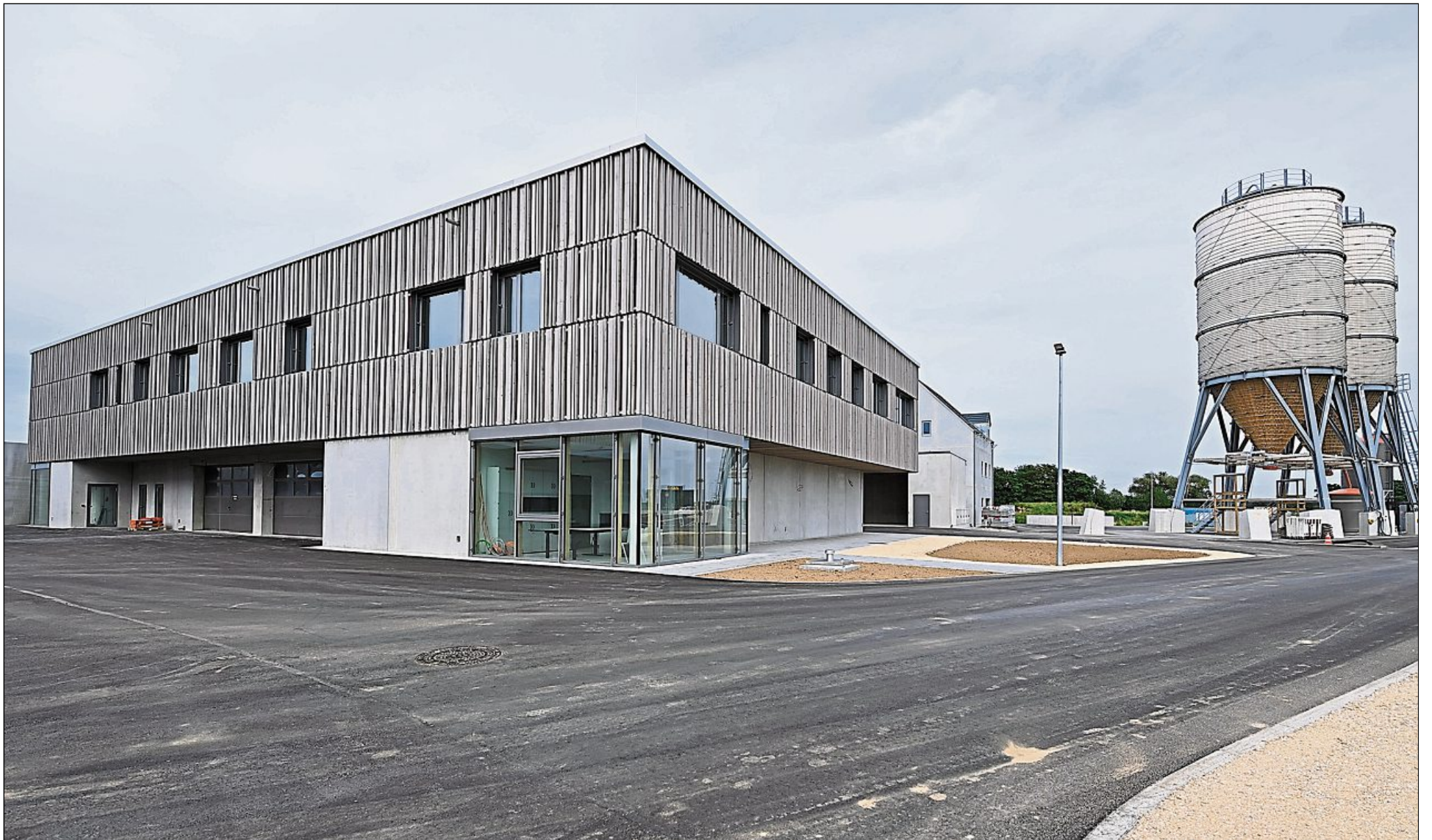
Das Verwaltungsgebäude mit seiner Holzfassade.
