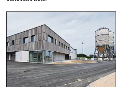
Das Verwaltungsgebäude mit den beiden Silos.
