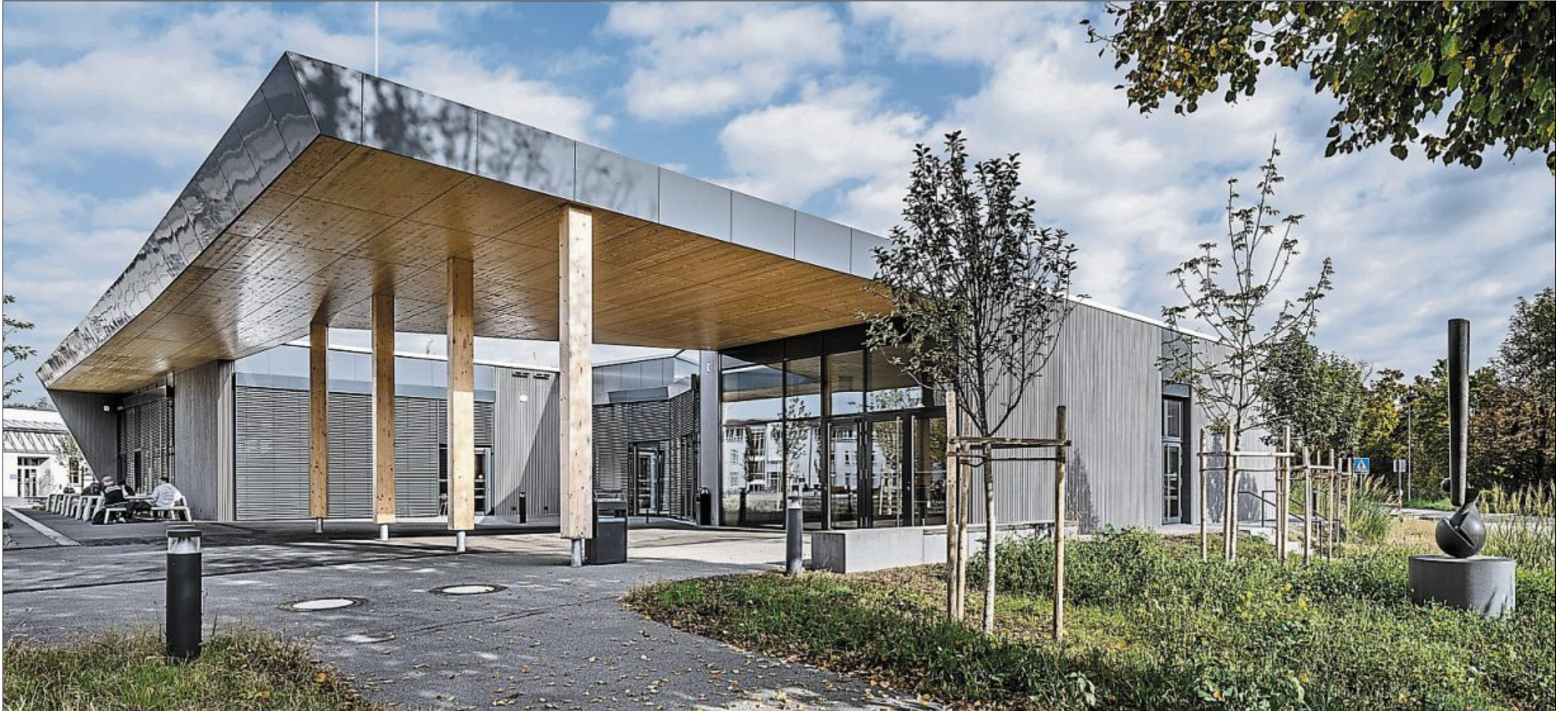
Der Eingangsbereich. Für den Neubau wurden insgesamt rund 300 Kubikmeter Holz für tragende Konstruktionen verbaut.
